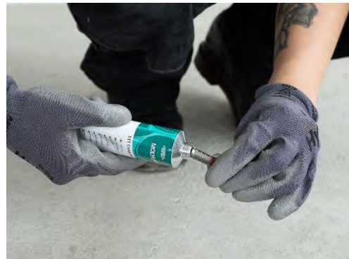
Bild SS4: Schlaganker fetten
