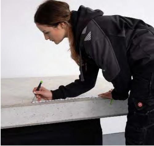
Anschliessend messen und dokumentieren Sie das Diagonalmass der eingezeichneten Punkte. Daraus errechnen wir den Winkel. Winkel anders als 90° können Sie nicht direkt online bestellen. Hier senden Sie uns die Massskizze zur Offertstellung.
